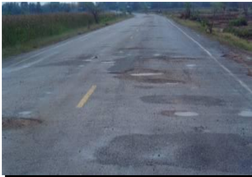
รูปที่ 2.4 ผิวทางลาดยางชำรุดเป็นหลุมเป็นบ่อ
