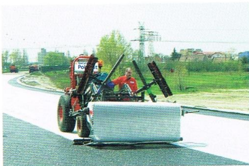
การติดตั้งทำได้ง่ายและรวดเร็วสามารถติดตั้งได้แม้เป็นแนวโค้ง
