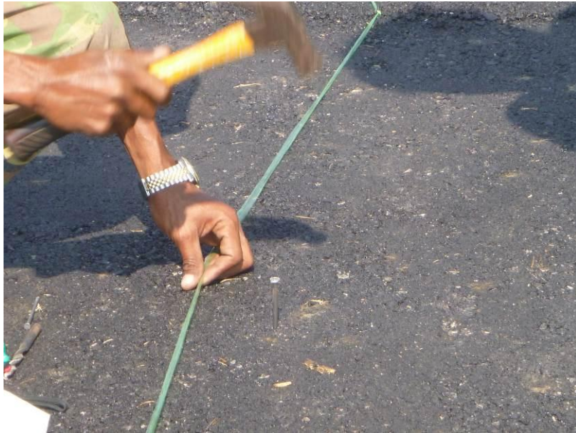
รูปที่ 4.5 ขั้นตอนการเจาะรูที่ผิวทางเพื่อจำลองรอยแตกไว้บนผิวถนน
