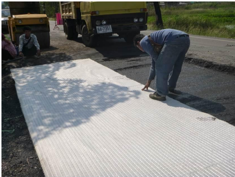
รูปที่ 4.6 ขั้นตอนการปูวัสดุสังเคราะห์
