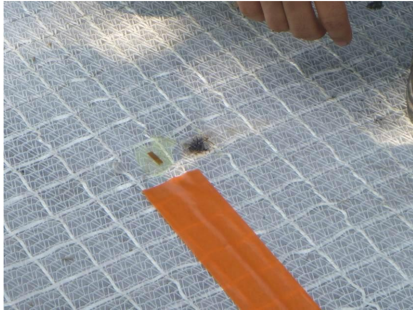
รูปที่ 4.9b ขั้นตอนการติดตั้ง Strain Gauge
