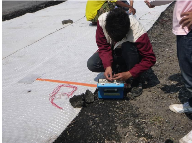
รูปที่ 4.9d ขั้นตอนการตรวจวัดค่า Strain Gauge
